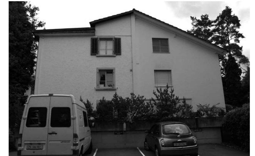
(5) Anbau an ein bestehendes Gebäude (rechter Teil) Zürich-Höngg
